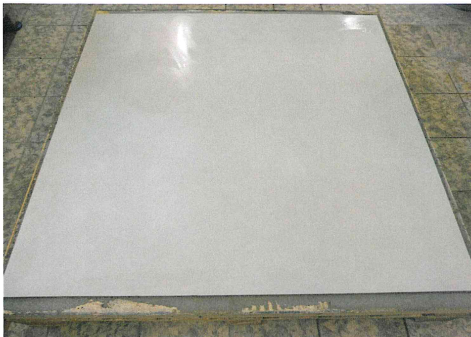
Bild 1: Verlegte Fliese 120 cm x 120 cm (auf Estrich)
